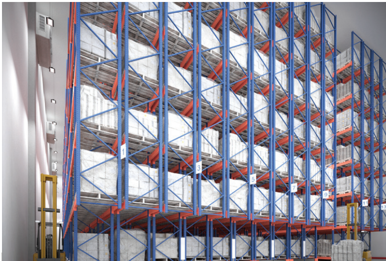
Морозильные блоки оборудованы узкостелажными системами
